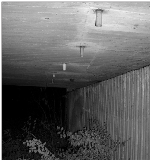
Obr. 1. Pohľad na zvislé kovové odtokové trubky na spodnej strane mostu, ktoré tvoria vstupný vletový otvor do dutín nad nimi (Foto: M. Celuch).
