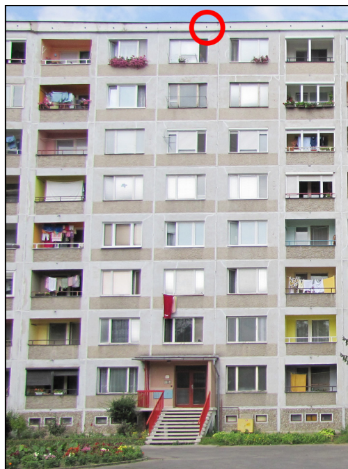
Obr. 2. Lokalizácia hniezda výrika lesného v paneláku (Foto: F. Bednár).
